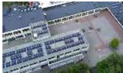
Zonnepanelen op dak SBS De Octopus
