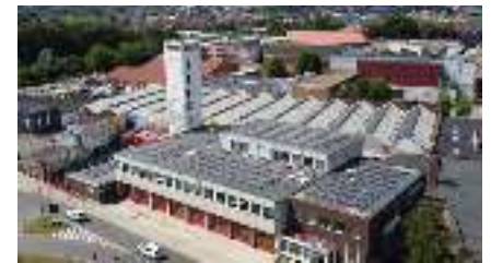
Zonnepanelen op dak brandweerkazerne
